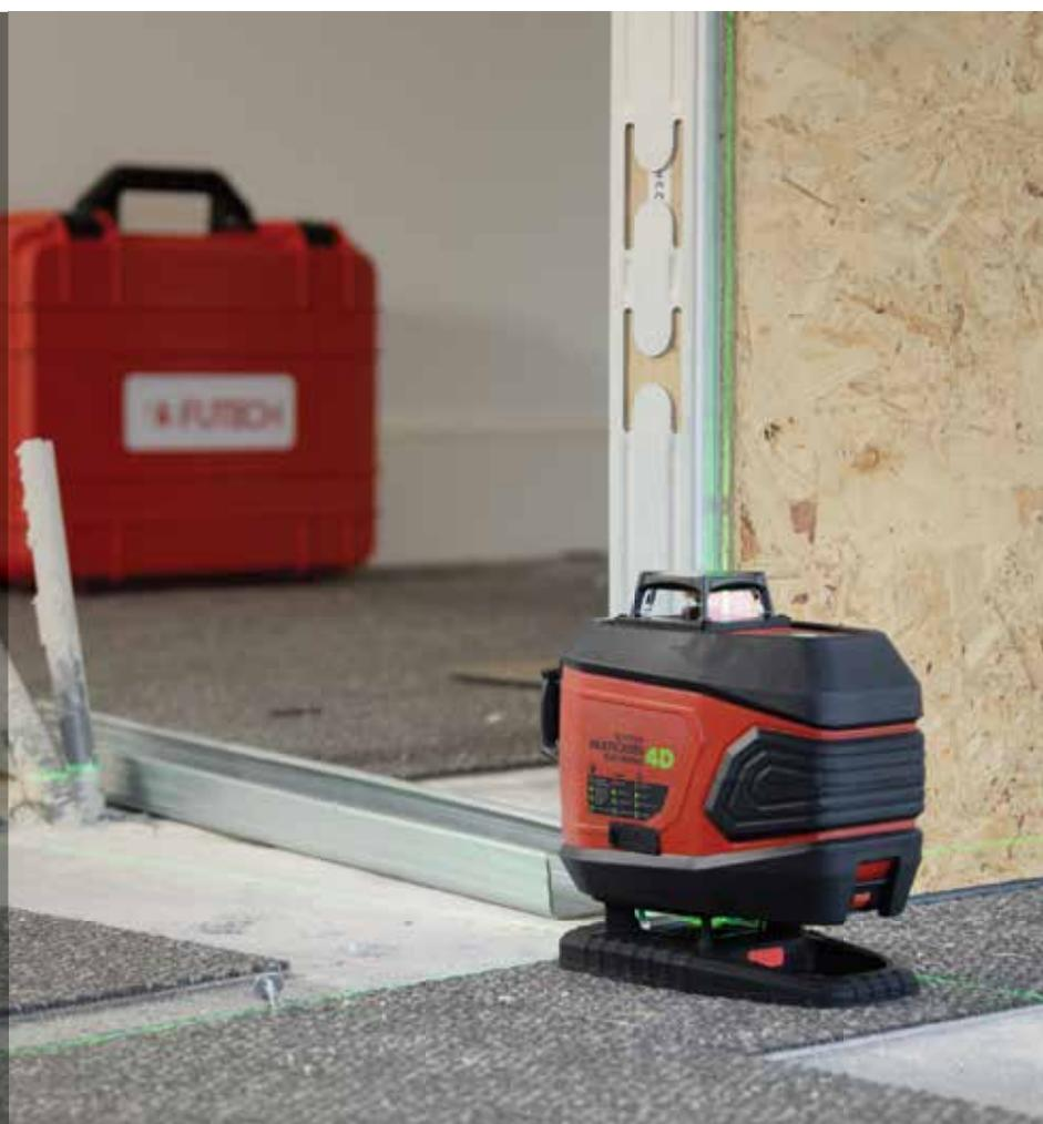
Zweite horizontale Linie 20 mm über dem Boden
